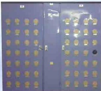
PANEL MODULAR NEMA 1, PARA 56 MEDIDORES HASTA 100 AMPERIOS, VISOR DE ACRÍLICO, CON TABLERO DE DISTRIBUCIÓN INTERIOR PARA RAMALES RESIDENCIALES DE 2 ò 3 POLOS HASTA 30 AMPERIOS POR LOCAL. MERCADO ZACATECOLUCA—2015.
