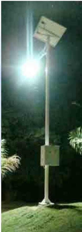
GABINETE PARA BATERÍAS DE SUMINISTRO DE ENERGÍA SOLAR, MONTAJE EN POSTE.
